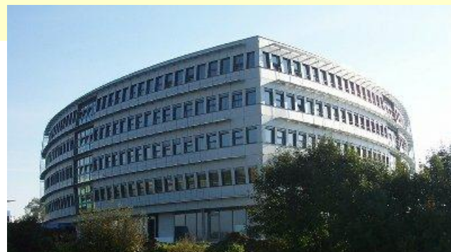
Pasywny budynek biurowy – Energon/Ulm, Architekci oehler + arch kom, Fot.: Oehler
