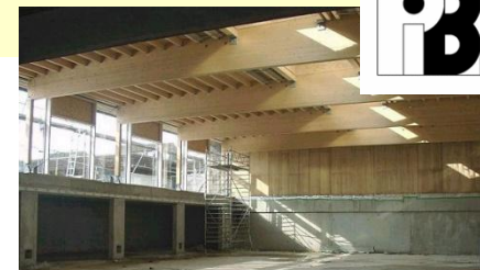
Hala sportowa- München-Unterschleißheim Architekt: Pfletscher und Steffan
