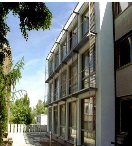
Hotel -Fernuniversität Hagen Architekt Ralph Wortmann
